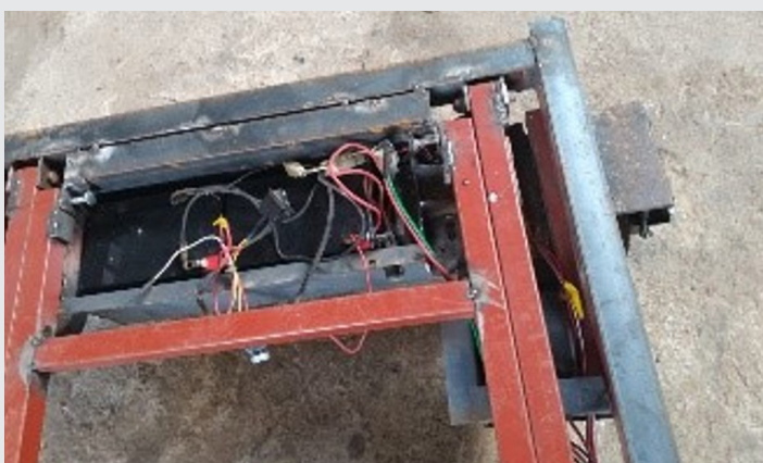
Figura 10. Instalación del motor eléctrico, acumuladores y cableado. Fuente Elaboración propia.
