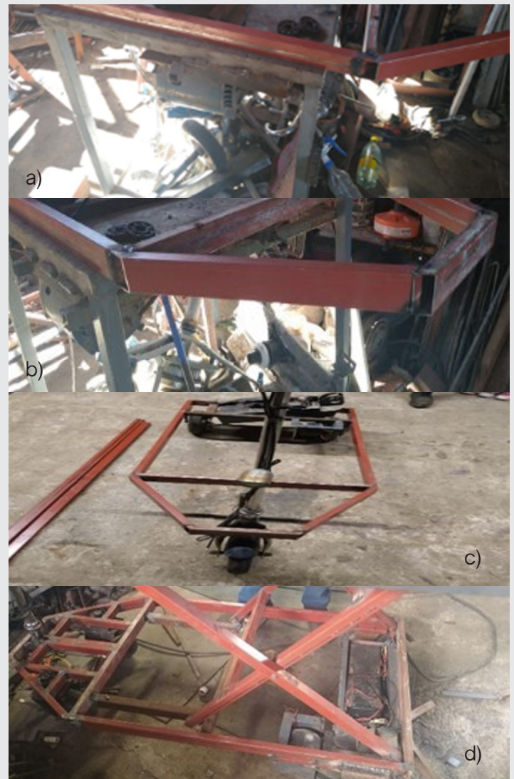
Figura 7. Proceso de construcción del patín eléctrico: a) Corte de elementos de chasis, b) Proceso de soldadura inicial de chasis, c) Montaje de manubrio y llantas, d) Armado del sistema de elevación de la plataforma. Fuente Elaboración propia.
